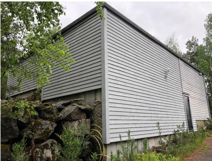
Figur 7: Høgdebassenget på Hosteland, eit plasstøypet basseng i betong på 430 m 3 .
