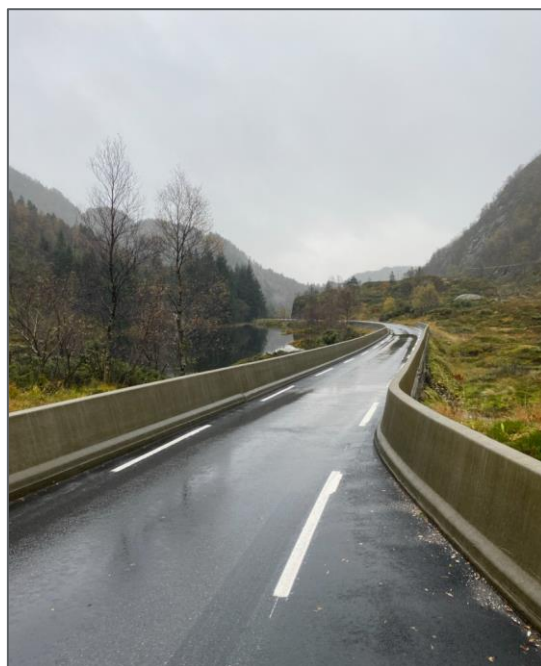
Figur 21: Fv571 - Kringlevegen v/Geirevatnet.
