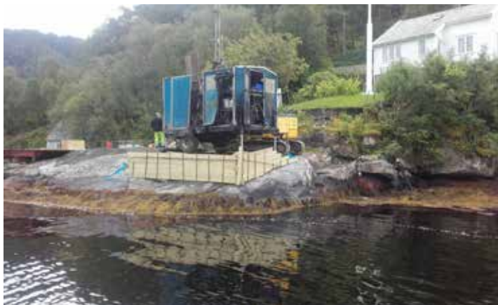
Kjerneboring – fundament til Masfjordbrua
