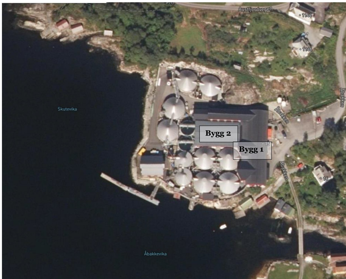
Figur 1. Flyfoto over anlegget slik det framstår i dag.
