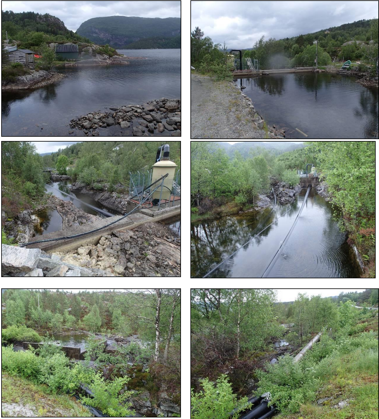
Figur 4. Inntaksstedet for ferskvann er Sørvingevatnet ( øverst til venstre ) der det er etablert en dam ved utløpet ( øverst til høyre ). Tre inntaksledninger sørger for vannforsyningen til anlegget, og disse går gjennom dammen via elveutløpet ( midten til venstre og høyre ) og videre under veien før de ledes på oppsiden av elveløpet og videre nedover til anlegget ( nede til venstre og høyre ), jf. figur 1 .
