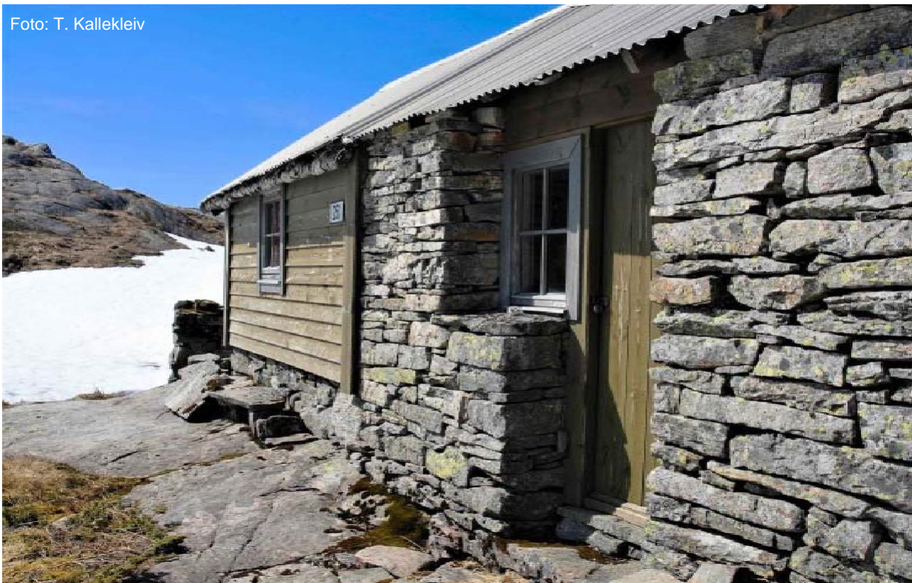
Ådnekvamsetra. Kunnskap i murarbeid kjem til nytte i dag også. Flott arbeid!
