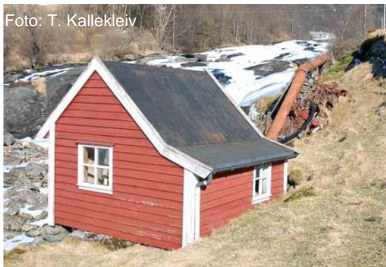
Minikraftverk på Nørland
