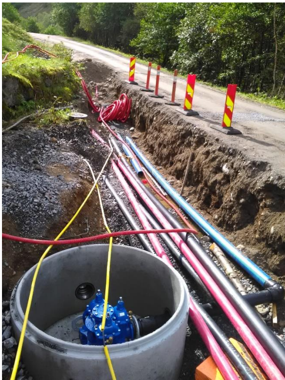
Figur 21: Utskifting av vasskum og vassleidning tilhøyrande Masfjorden vassverk.
