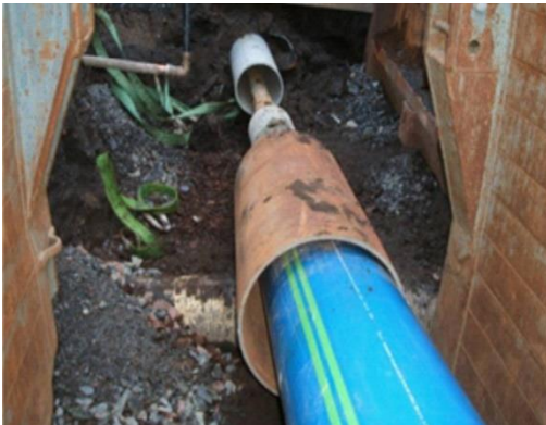
Figur 19: Eksempel på utblokking (kjelde: VA Miljøblad)
